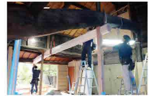
梁を追加して耐震補強
