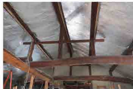
屋根裏に断熱材を入れて暖かく
